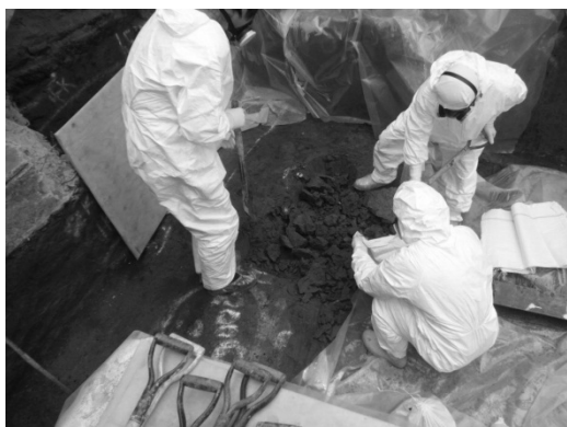
建家と引込溝接続部下部の汚染土壌撤去
