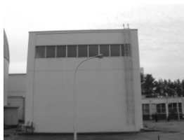
保障措置技術開発 試験室施設 (SGL)
