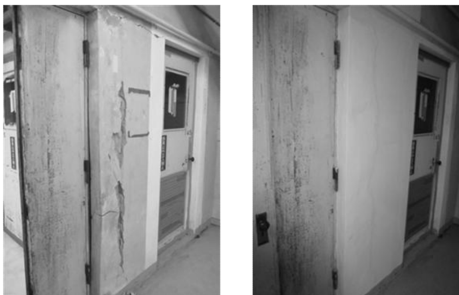
図 3.5-1 再処理特別研究棟本体施設 133 号室 (左：補修前、右：補修後)
