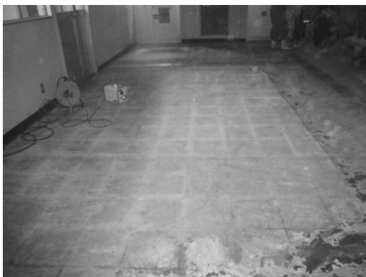
研修生実験室の床材撤去跡
