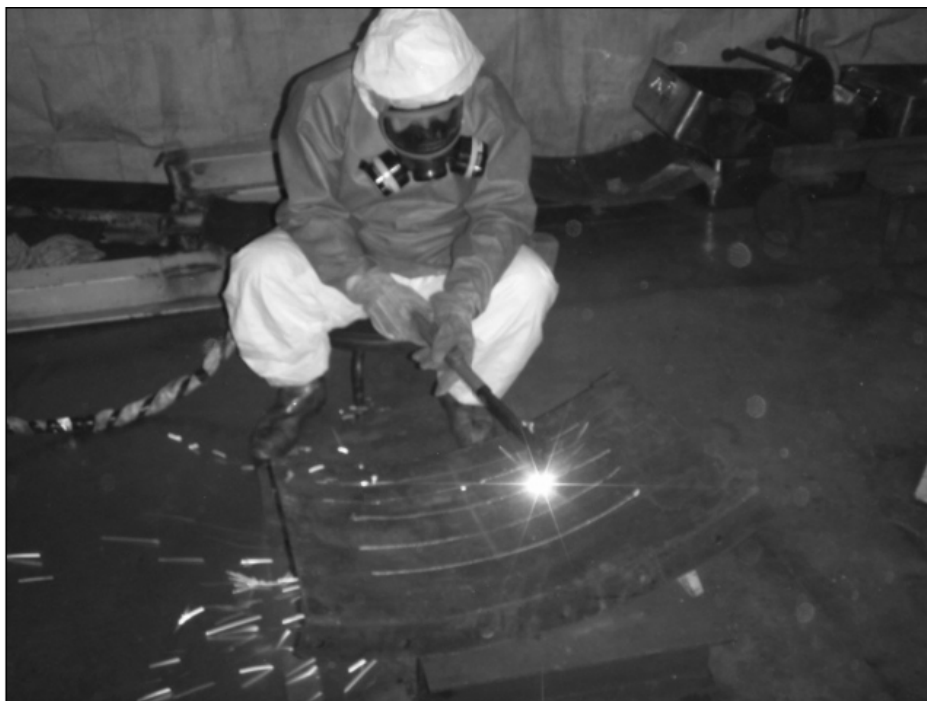
図 4.4.2-3 プラズマ切断機による切断
