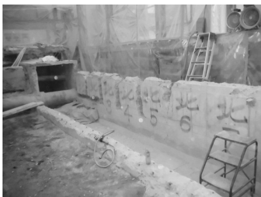
引込溝上部の撤去（放射性廃棄物でない廃棄物）
