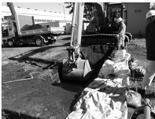
引込溝周辺の土壌掘削
