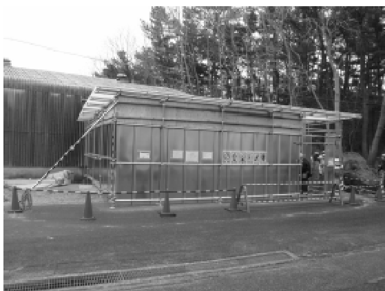
第2排水溝上部への仮設上屋の設置
