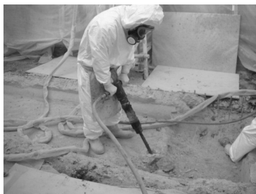
引込溝下部の撤去（汚染閉じ込め部）
