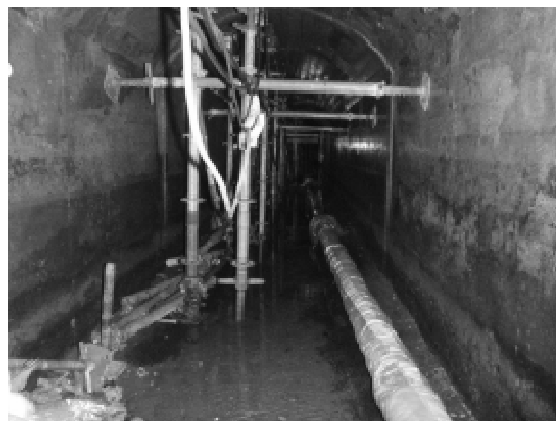
第2排水溝内の補強材の設置状況(移動後)
