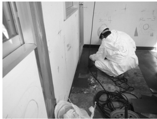
研修生実験室の床材撤去
