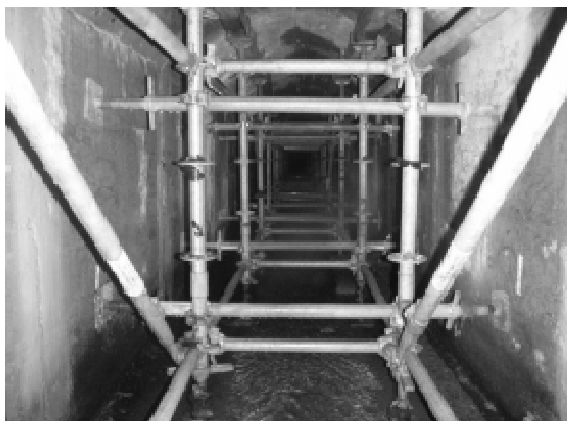
第2排水溝内の補強材の設置状況(移動前)
