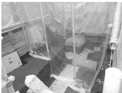
建家と引込溝接続部下部の汚染土壌撤去跡
