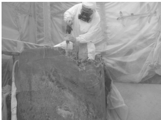
コンクリート製マンホールの解体
