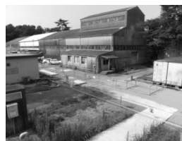
モックアップ試験室建家
