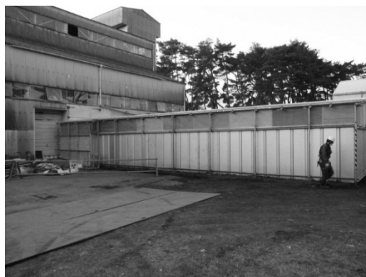
仮設上屋の設置
