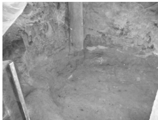
コンクリート製マンホール撤去跡
