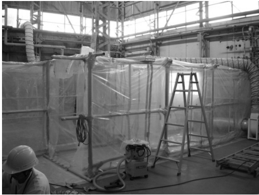
大実験室内グリーンハウスの設置
