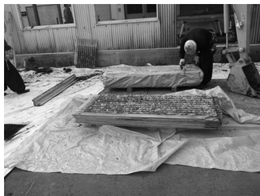
計算機室外壁の撤去・梱包
