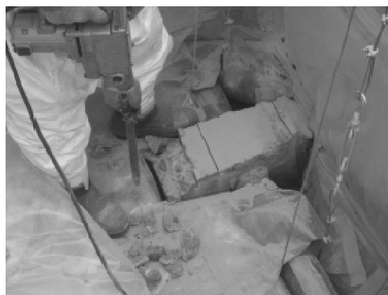
コンクリートキャッチの取り外し作業
