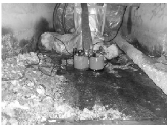
第2排水溝内の浸入水対策状況
