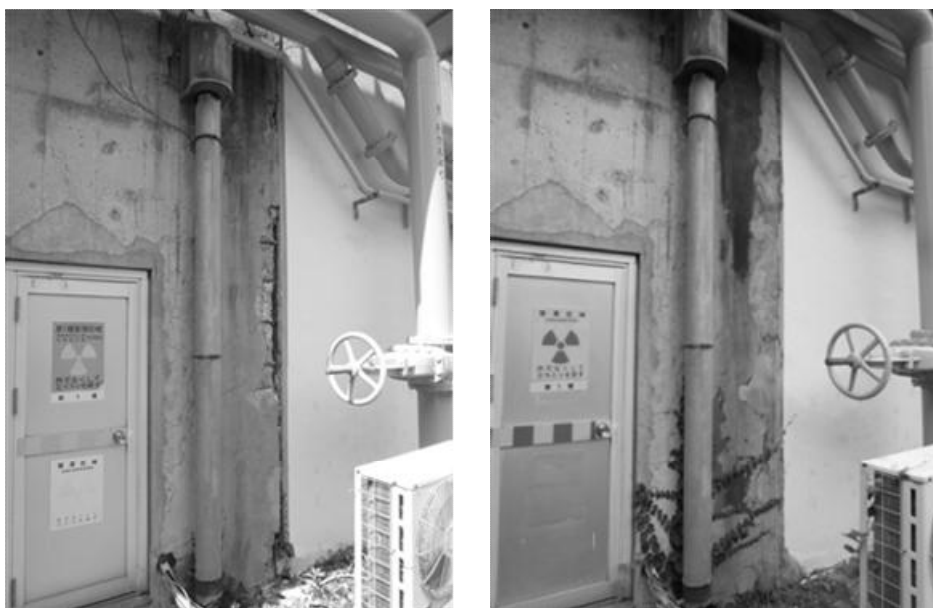
図 3.5-2 再処理特別研究棟本体施設屋外 III 棟、IV 棟エクспанション部 (左：補修前、右：補修後)
