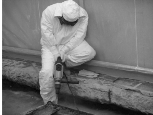
大実験室床材はつり作業
