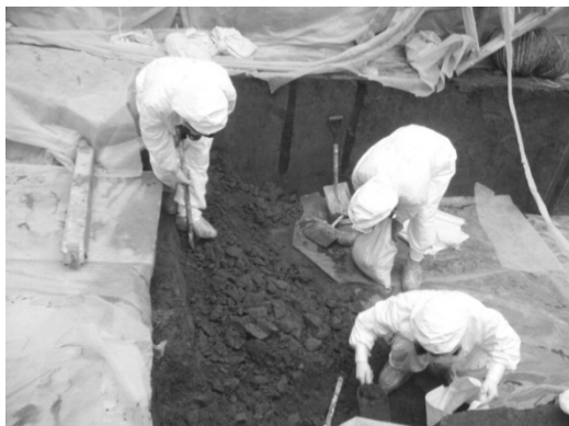
汚染土壌の撤去
