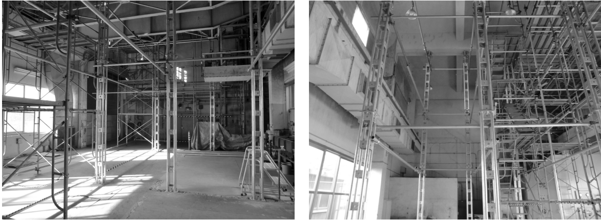
図 3.3-1 15ton クレーン室の補強措置の状況
