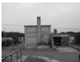
ウラン濃縮研究棟
