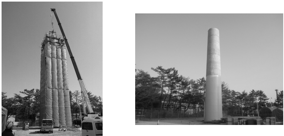
図 3.3-2 排気筒の補修の状況
