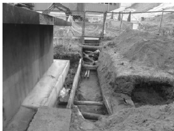
埋設部等の事前調査作業状況
